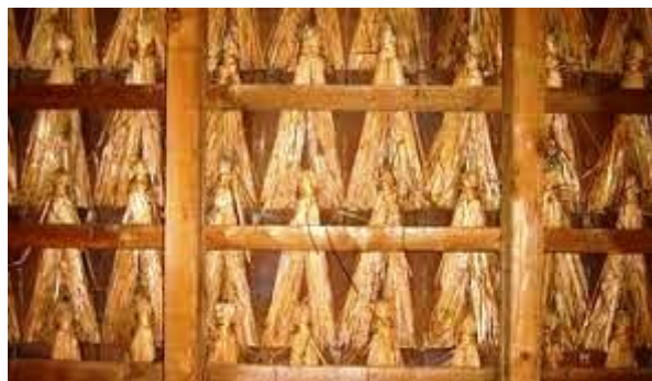
Innenansicht eines mit Schöpfen versehenen Tonziegeldaches
