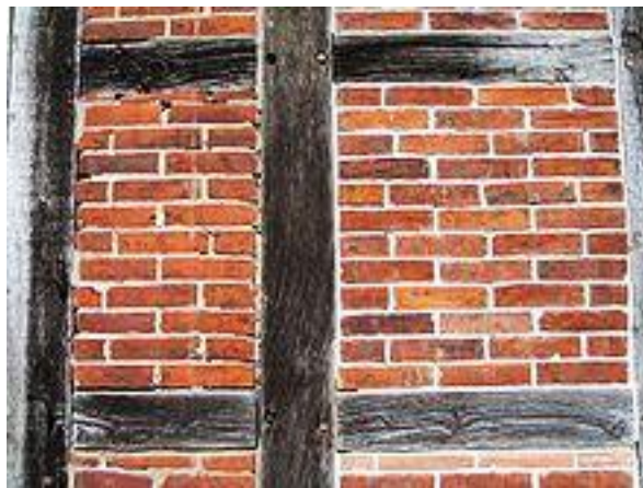
Sichtmauerwerk, links: alt, rechts: erneuert
