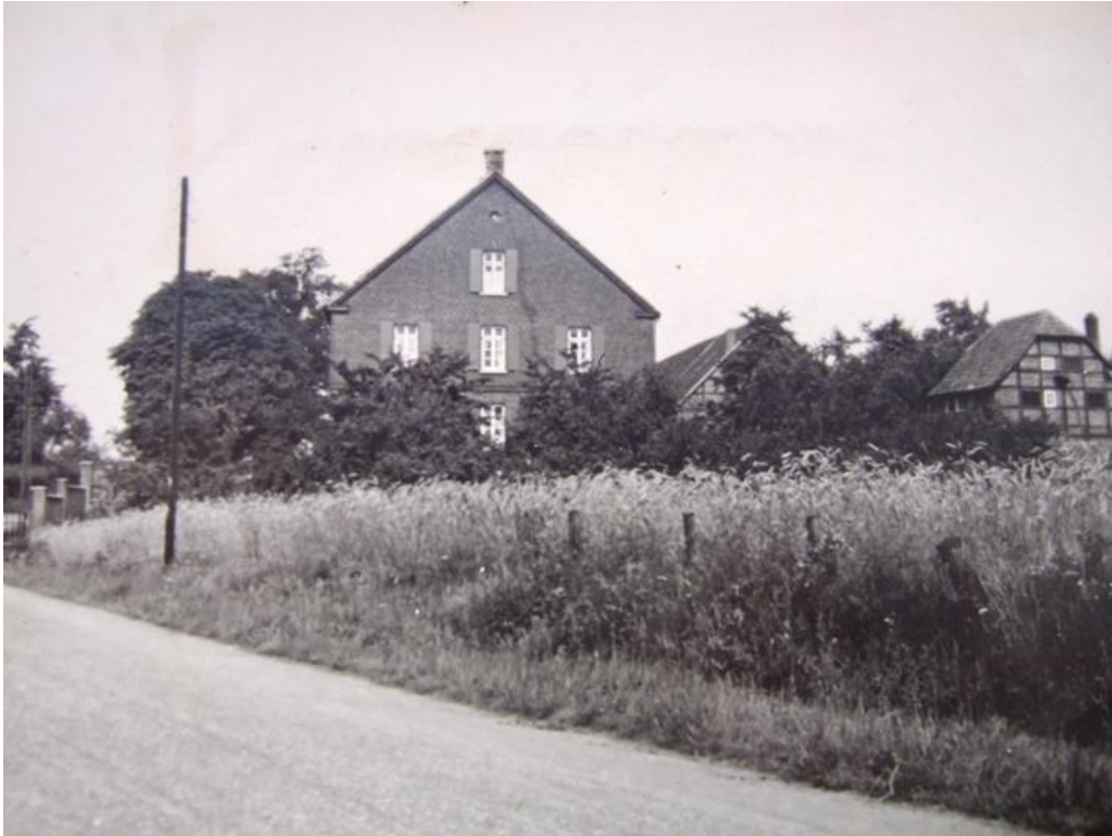
Abb. 14: Der Hof Klothmann mit Scheune (Mitte rechts) und Backhaus (ganz rechts) mit seinem Krüppelwalmdach; Aufnahmejahr ca. 1937
