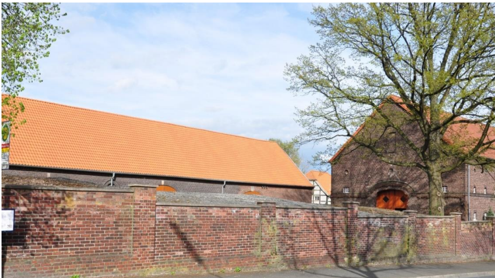
Der Bauernhof von Süden aus gesehen. Zwischen 1871 erbauter Scheune und dem Haupthaus das von Johann Diederich Friedrich Bürger, dem Bruder Heinrichs, errichtete Backhaus, das auch als Speicher für das gedroschene Getreide diente. Die Mauern ließ mein Großvater Wilhelm Klothmann in den dreißiger Jahren des 20. Jahrhunderts erbauen.
