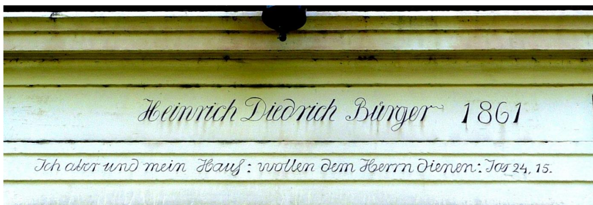
Der Türsturz oberhalb des nordseitigen Einganges zum Wohntrakt des Gebäudes
