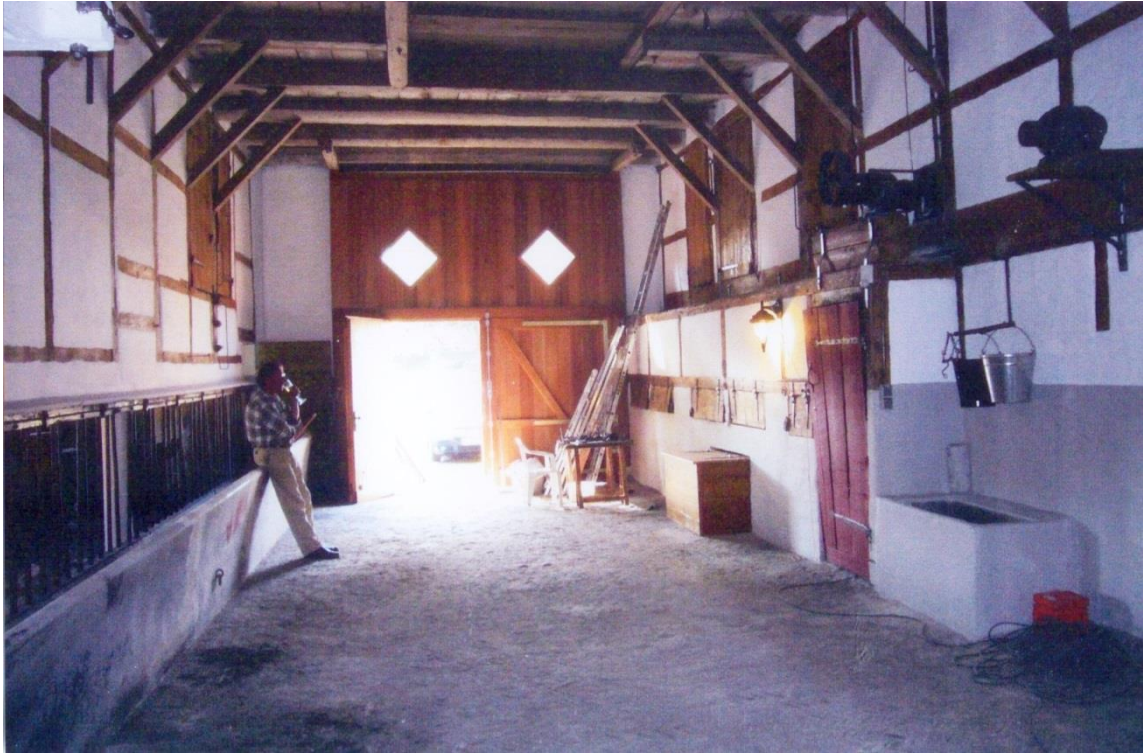
Die Dehle nach Westen: links der in den dreißiger Jahren des 20. Jahrhunderts modernisierte Kuhstall, rechts der Pferdestall, rechts daneben die Tränke. In der Holzdecke Luke zum Einführen des Heus. Der Fußboden besteht aus einem original erhaltenen Pflaster aus kartoffelgroßen Feldsteinen
