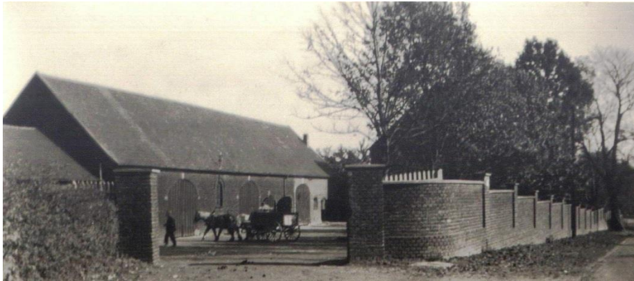
Abb. 3: Die Scheunen mit der Unterfutter (hinter dem Eintonner-Wagen fast verdeckt); ca. 1953
