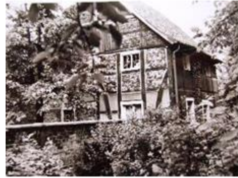
Backhaus von Südwest im Erdgeschoß (alte Backstube) Gefache teils unverputzt
