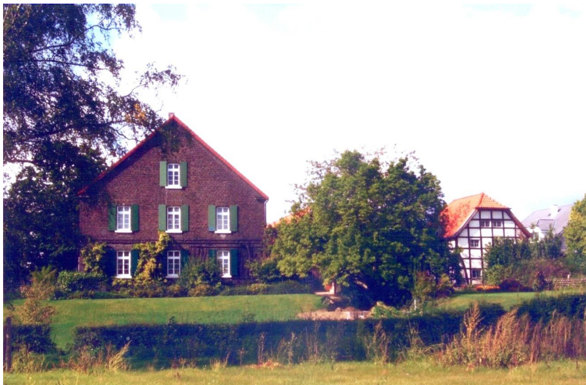
Der Hof Klothmann von Osten ca. 2010, rechts das Fachwerk Backhaus von 1836. Abweichend vom Originalzustand des Sichtmauerwerkes war diese Seite des Hauses schon in den vierziger Jahren verputzt worden. Mein Bruder hat auch die übrigen Flächen putzen und weiß streichen lassen.
